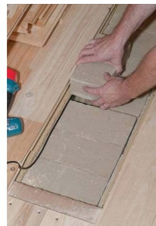
Bild: Verschiedene Deckenfüllungen werden mit Messsonden versehen (Foto: Kay Arnswald)
